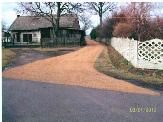
Wyremontowana droga w Chwostku
