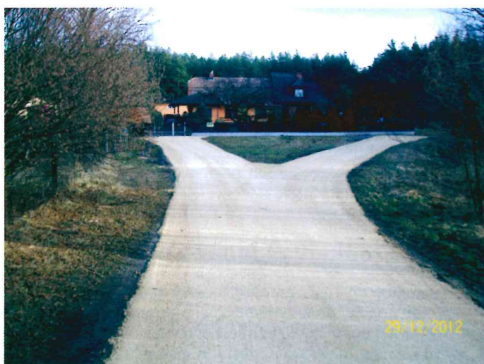
Odcinek drogi w Taninie po remoncie
