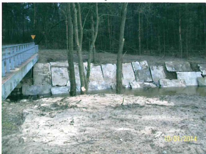
Wykonane umocnienia rzeki przy moście w Taninie
