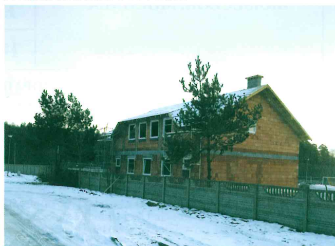
Budowa budynku socjalno-administracyjnego na boisku w Lisowie
