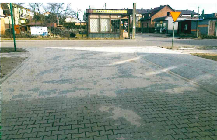
Nowy wjazd przed blokiem Budowlanych 11
