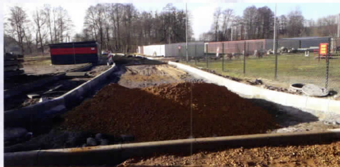
Remont odcinka ul. Budowlanych dojazd do garaży
