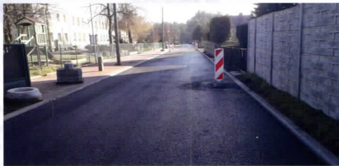
Remont ulicy Szkolnej w Lisowie
