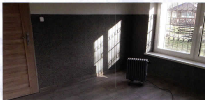
Remont pomieszczeń w budynku sportowca w Hadrze
