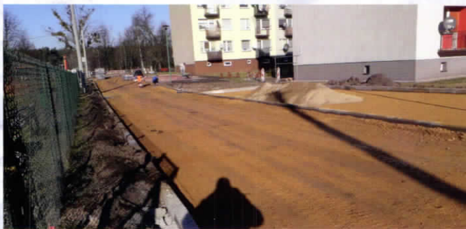
Remont ulicy Budowlanych w Lisowie
