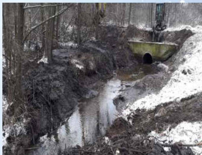
Remont przepustu po szkodach wyrządzonych przez bobry na rz. Kalinka
