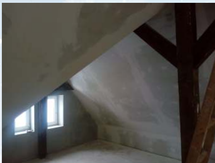
Docieplenie stropu i dachu w budynku Urzędu Gminy
