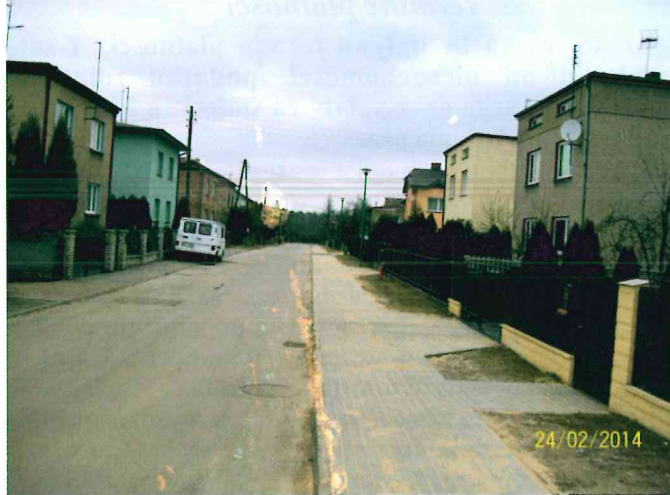
Uzupełnienie chodnika na ul. Sienkiewicza w Herbach
