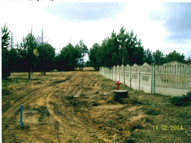
Budowa wodociągu na ul. Południowej w Olszynie
