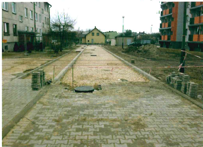
ul. Witosa 5 w Lisów w trakcie remontu
