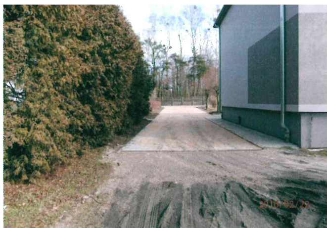
Utwardzenie wjazdu – Mochata ul. Fabryczna 4
