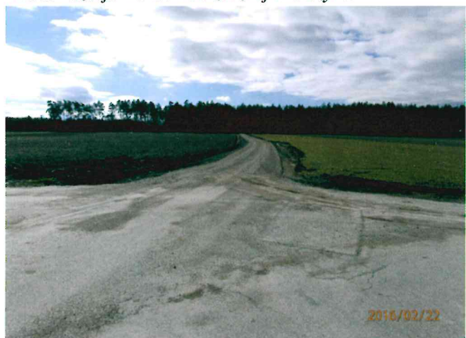
Droga w Niwach w kierunku Ostrów po modernizacji
