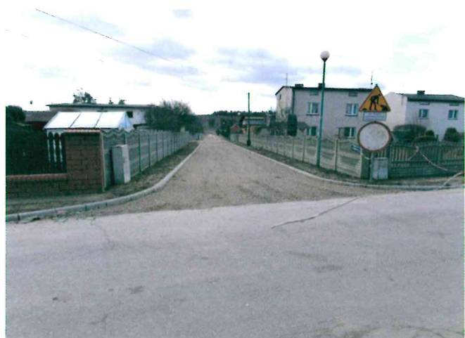
Modernizacja na ul. Nadrzecznej w Olszynie
