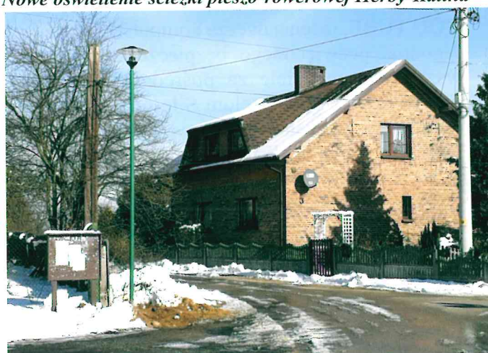
Nowa lampa na skrzyżowaniu w Kolonii Lisów
