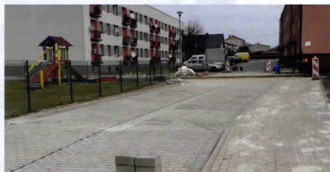
Remont ul. Budowlanych – odcinek przy placu zabaw
