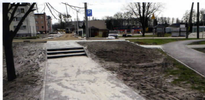
Remont ul. Budowlanych – przejście od ul. Częstochowskiej
