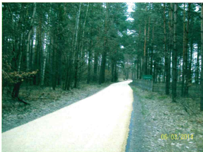
Modernizacja drogi Otrzęsie Oleksiki
