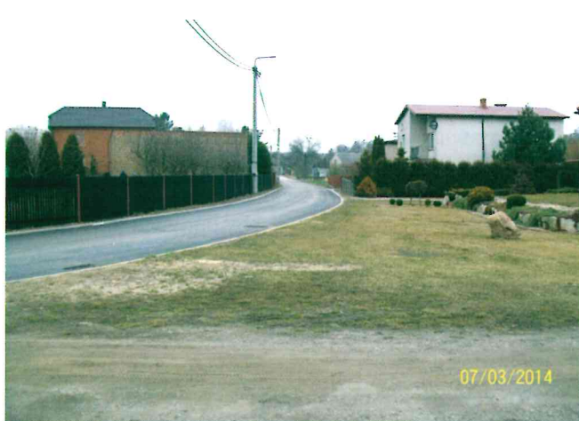
Ulica Miarki w Chwostku po modernizacji
