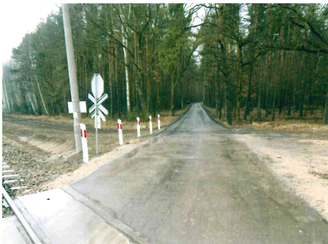
Droga Otrzęsie-Lisów po modernizacji
