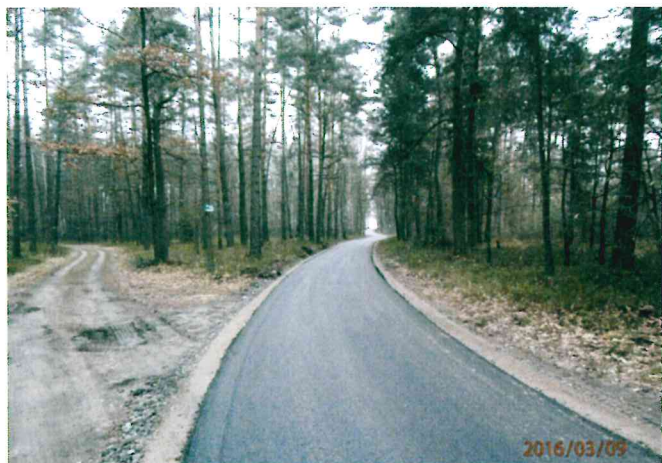
Droga Ostrów -Niw od strony Ostrowa –asfalt
