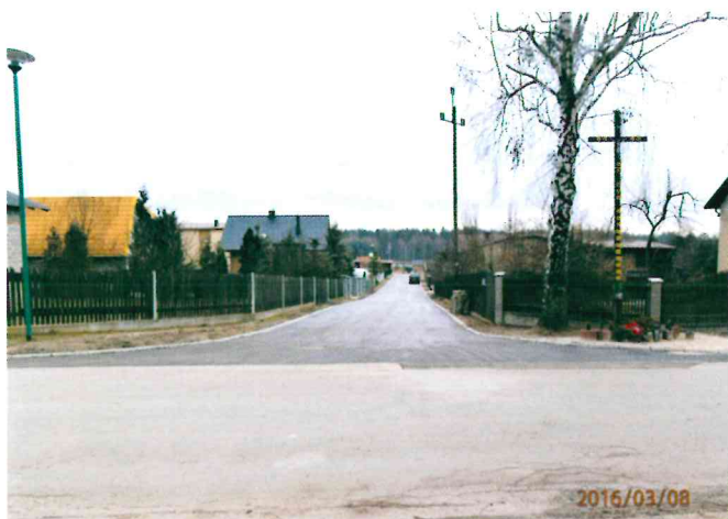
Ulica Krótka w Olszynie – asfalt
