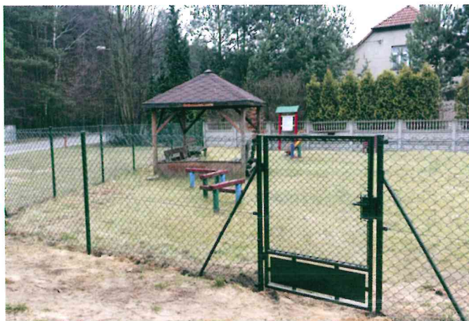
Wymiana siatki ogrodzeniowej na placu zabaw w Herbach
