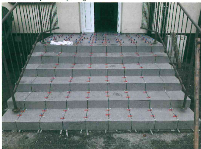
Remont schodów wejściowych do OSP Tanina
