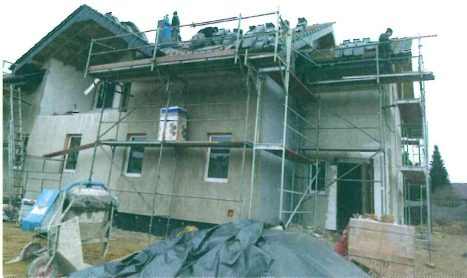
Budowa budynku socjalnego na boisku LKS Lisów
