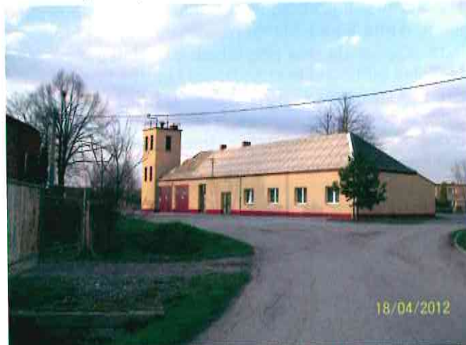
Remont dachu na remizie OSP w Chwostku
