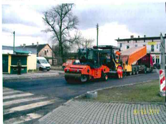
Remont ulicy Dworcowej w Herbach
