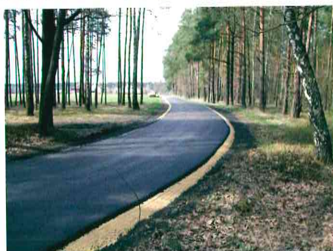
Remont odcinka drogi Hadra-Olszyna
