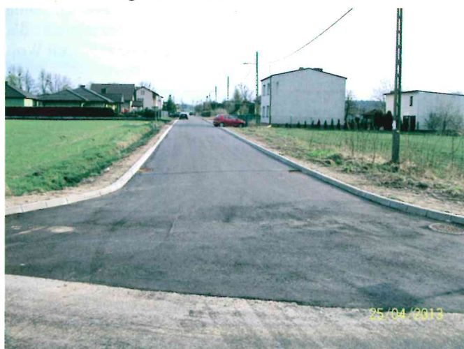
Ulica Dworcowa w Lisowie po modernizacji
