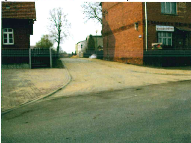
Wykonany remont części ul. Sportowej w Olszynie
