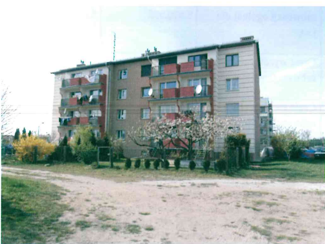
Termomodernizacja budynku WM w Lisowie ul Witosza 3
