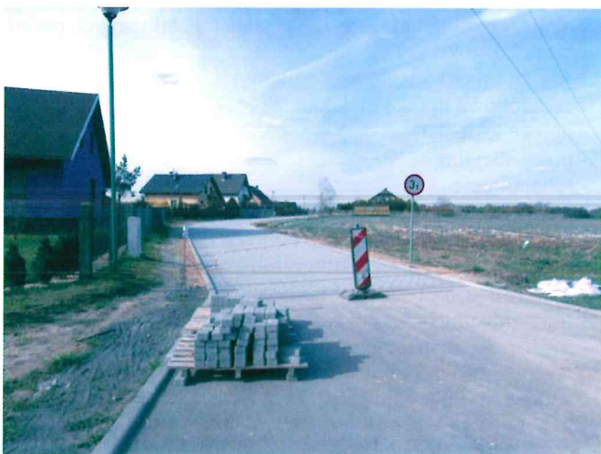
Modernizacja ulicy Paprotnej w Lisowie
