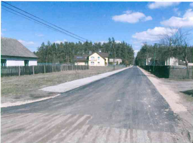
Asfalt na ul. Leśnej w Taninie
