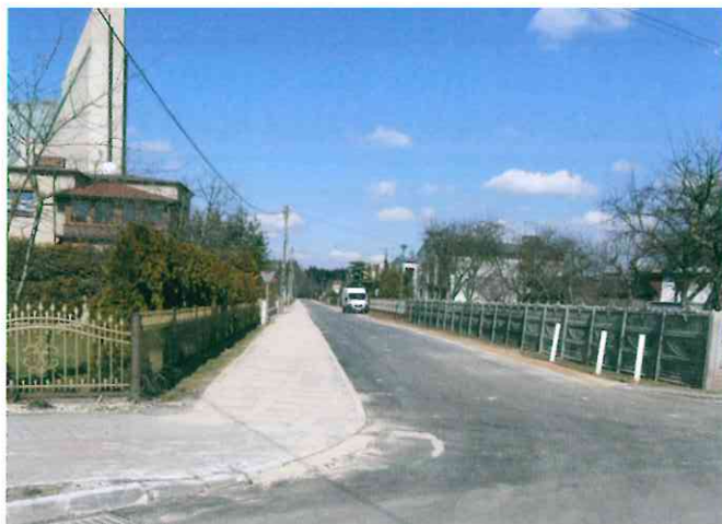
Ulica Poprzeczna w Lisowie po remoncie
