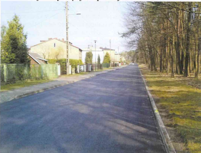
Nowa nawierzchnia na ul. Nowej w Herbach
