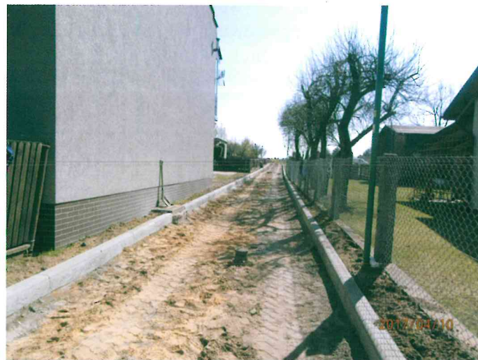
Prace remontowe na ul. Cichej w Olszynie
