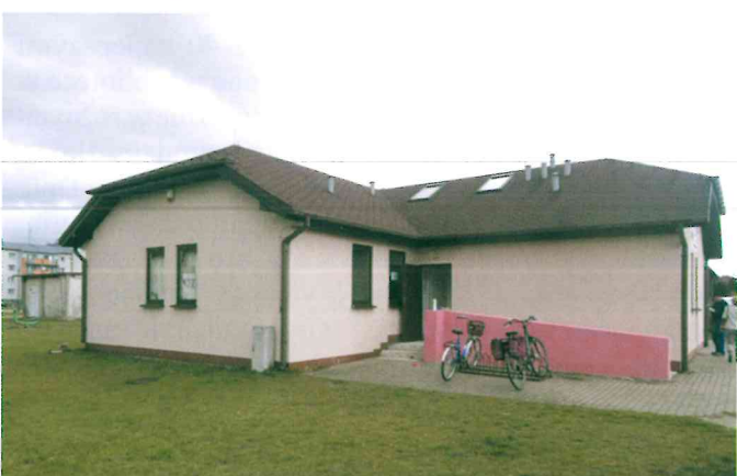
Ośrodek Zdrowia w Lisowie w trakcie remontu
