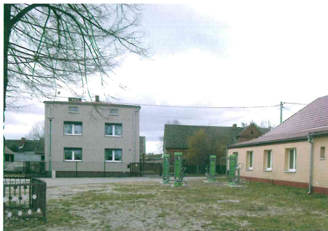
Montaż urządzeń siłowni w Chwostku
