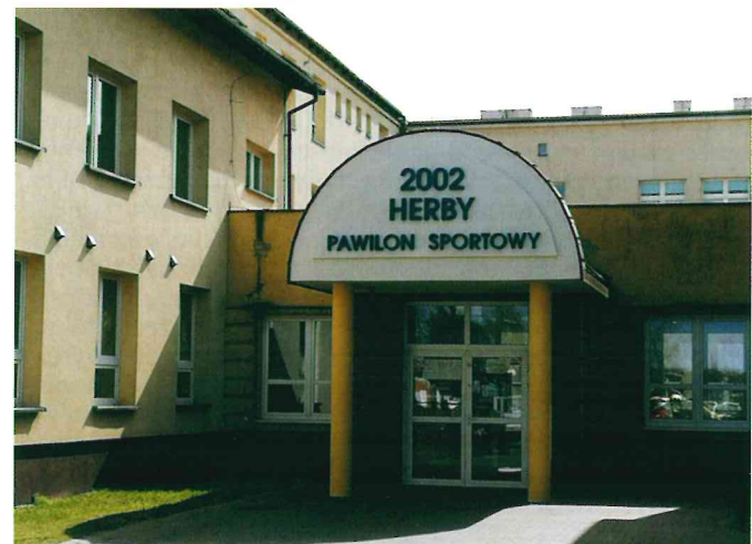
Wejście na halę sportową w ZPO Herby po odnowieniu
