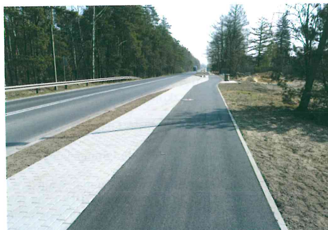
Postęp prac na drodze rowerowej – odcinek w Herbach
