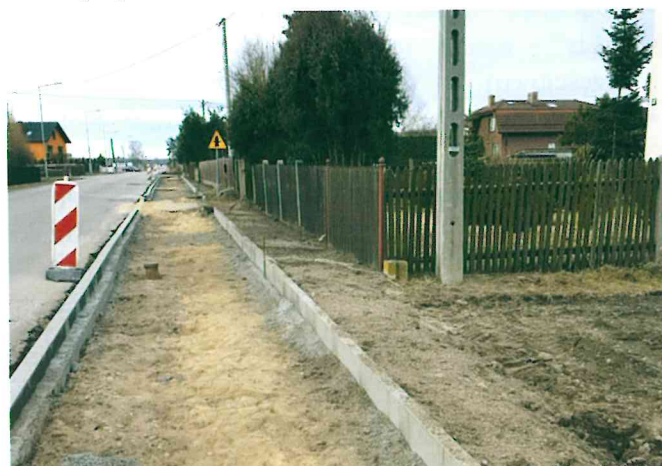
Budowa drogi rowerowej w Chwostku
