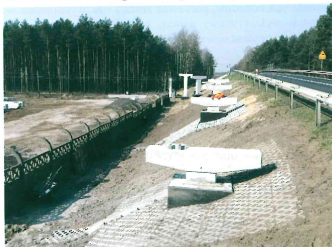
Prace przy kładce na drodze rowerowej w Herbach
