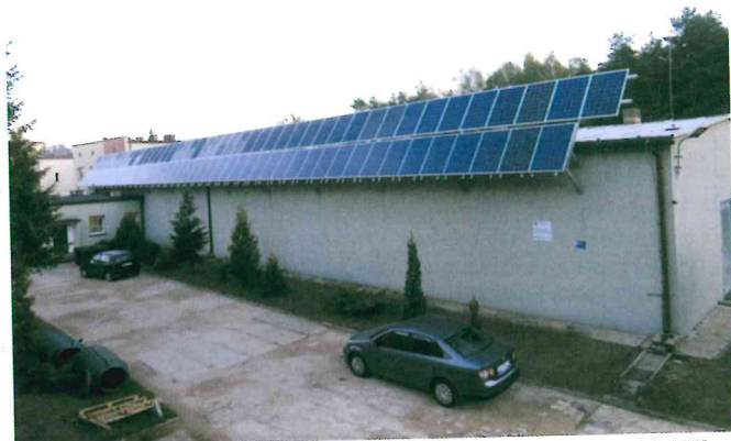
Nowy moduł ogniw fotowoltaicznych na SUW o mocy 11 kW
