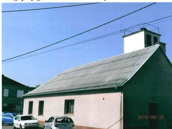
Remont rynien i podbitki na budynku remizy OSP w Lisowie
