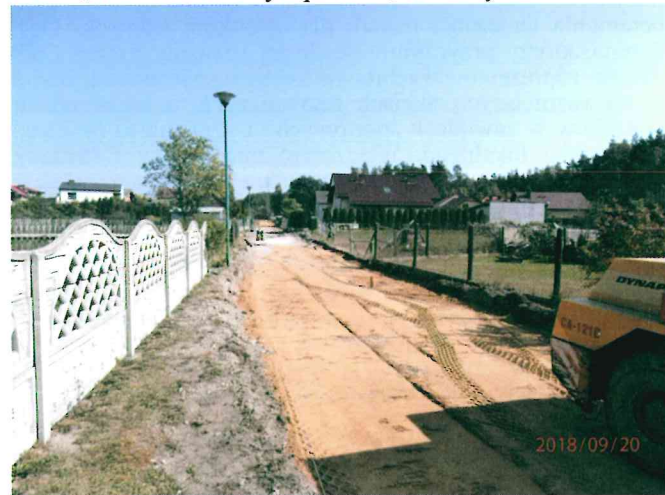
Prace remontowe na ul. Orzechowej w Lisowie
