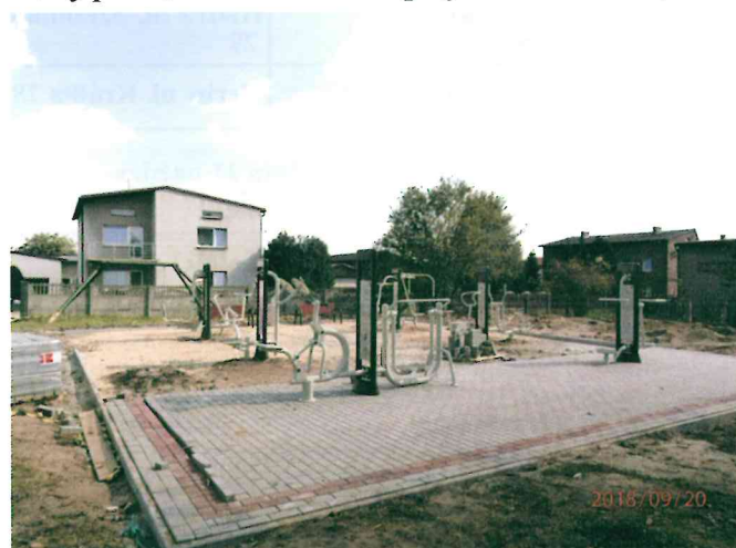
Montaż siłowni na wolnym powietrzu w Olszynie
