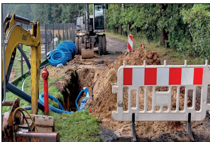
Budowa kanalizacji na ul.Sosnowej w Lisowie
