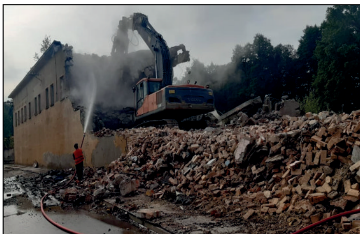
Rozbiórka budynków po garbarni w Mochali
