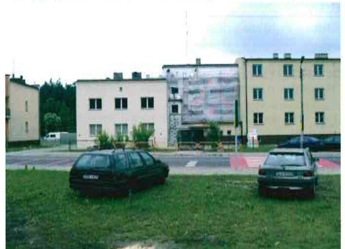
Termomodernizacja starej części budynku ZPO w Herbach
