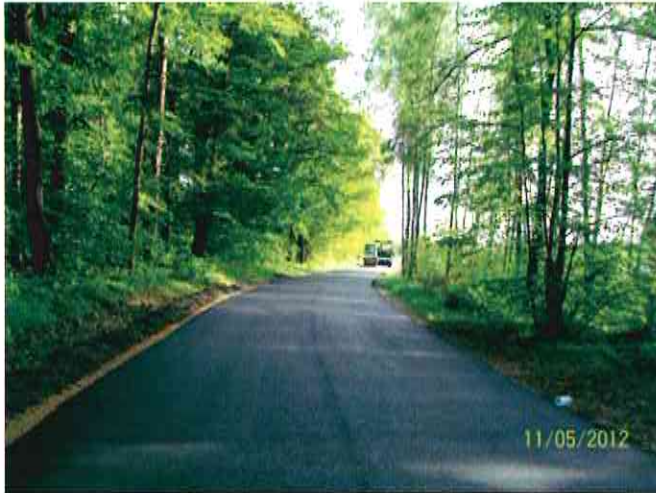
Remont ul. Wczasowej w Pietrzakach
