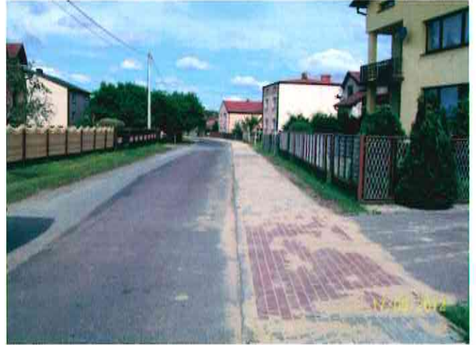
Nowy chodnik w Kalinie ul. Strażacka kontynuacja prac
