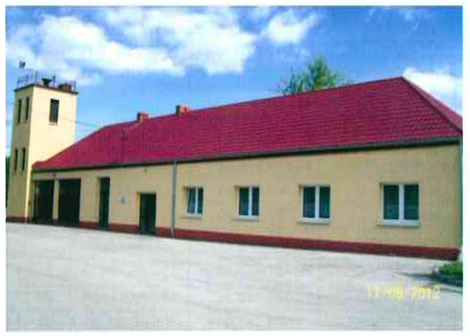
Nowy dach na remizie OSP w Chwostku
