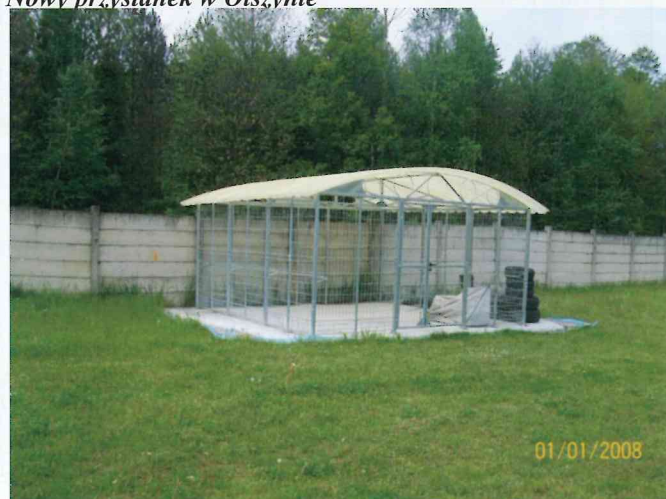
Punkt selektywnej zbiórki odpadów na oczyszczalni w Herbach
