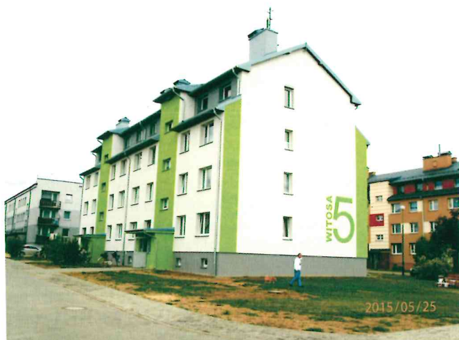
Termomodernizacja bloku Witosza 5 w Lisowie
