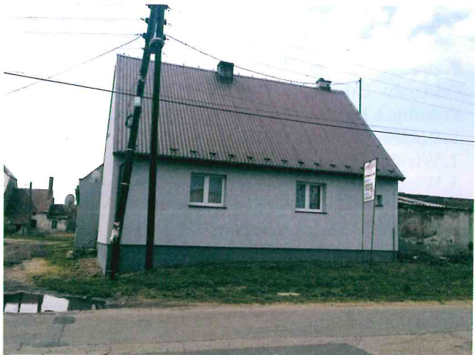
Budynek komunalny w Hadrze ul. Koszęcińska 9a po remoncie
