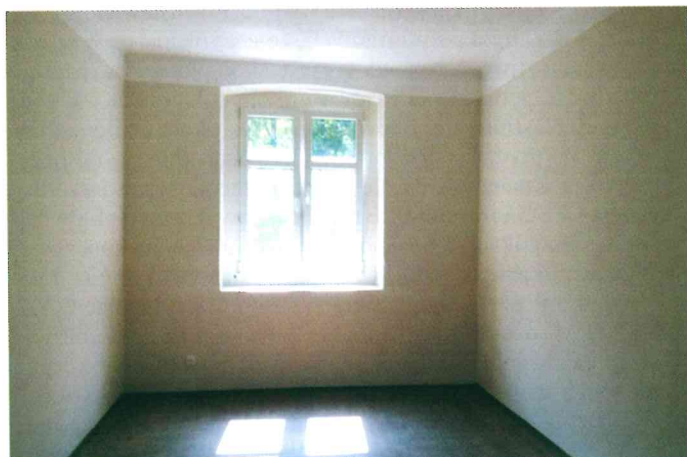
Wyremontowane mieszkanie socjalne w Braszczoku
