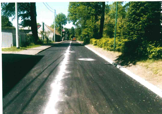
Nowy asfalt na ul. Fabrycznej w Mochali
