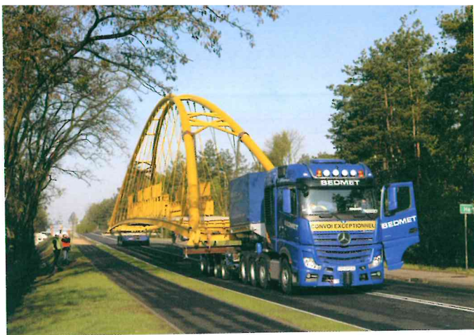
Rozpoczęcie prac przy montażu kładki w ciągu drogi rowerowej
