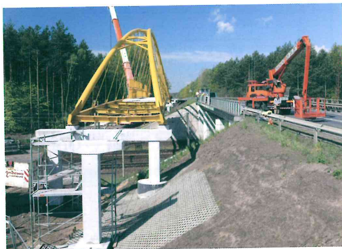
Montaż kładki zakończony sukcesem
