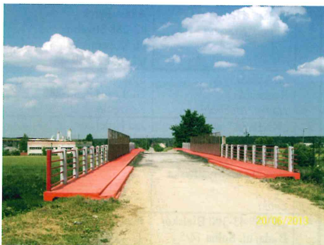
Remont mostu w Ameryce
