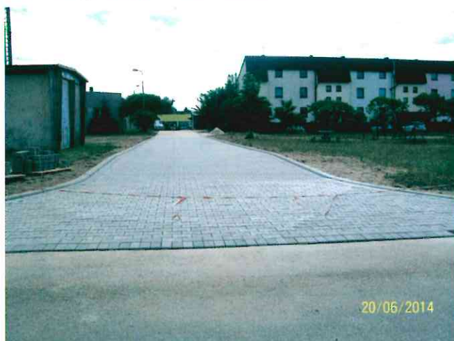
ul. Handlowa w Lisowie po remoncie
