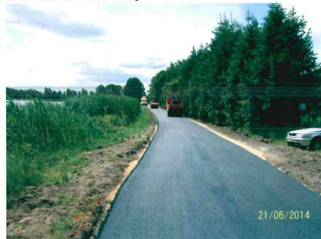
Droga w Pilce po remoncie
