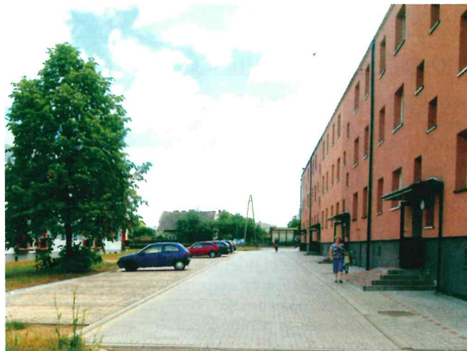
Nowy parking przy ul. Budowlanych 11 w Lisowie
