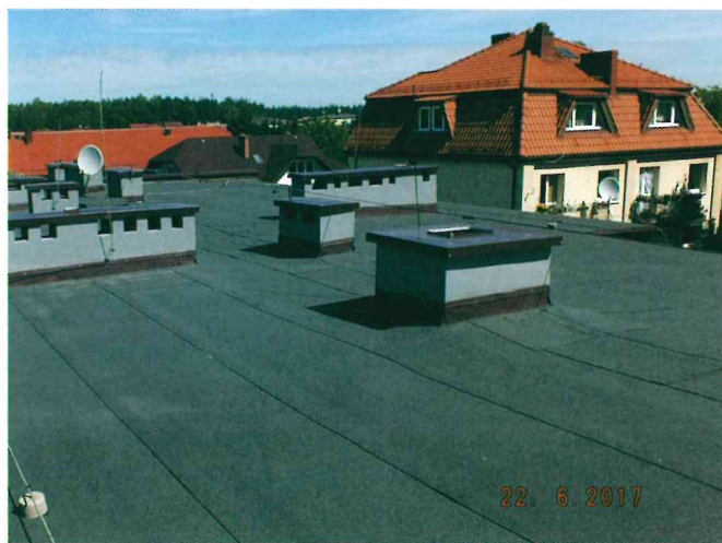
Dach na środku zdrowia w Herbach przy ul. Powstańców po remoncie
