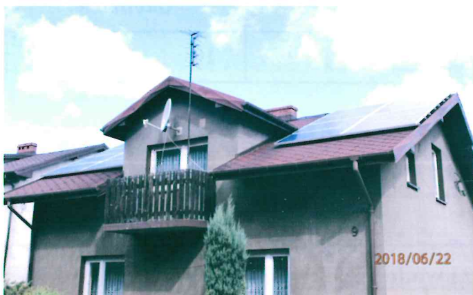
Montaż paneli fotowoltaicznych w gminie
