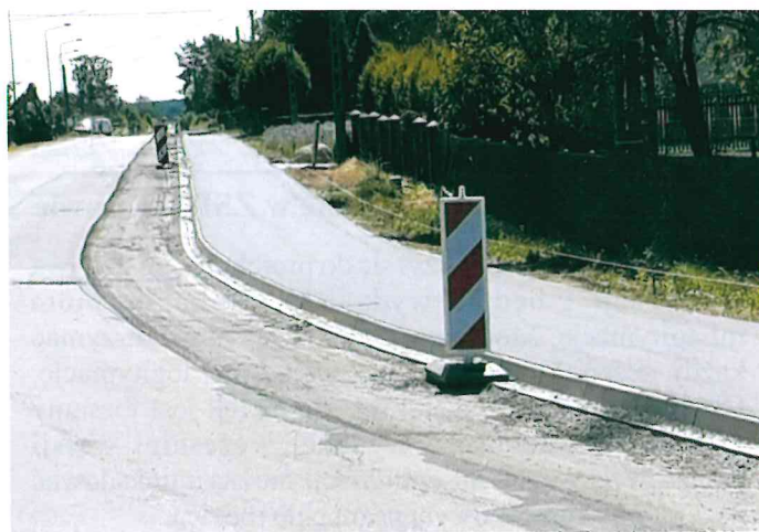
Postęp prac na drodze rowerowej Lisów - Chwostek
