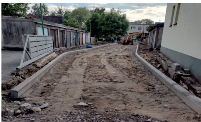
Przebudowa ul. Budowlanych w Lisowie - droga do garaży
