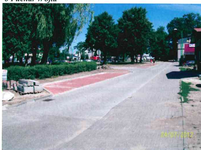
Nowa nawierzchnia na ul. Dworcowej w Herbach
