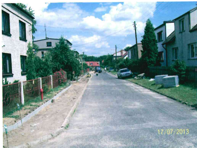
Budowa chodnika na ul. 1 Maja w Herbach
