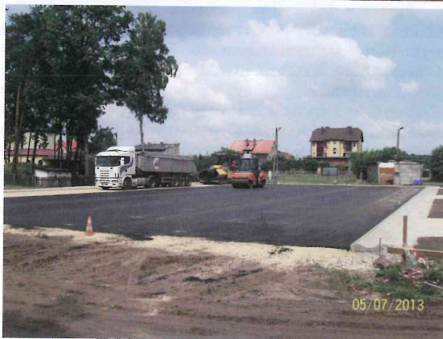
Budowa boiska wielofunkcyjnego w Herbach
