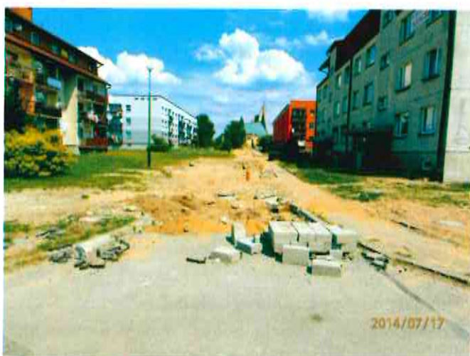
Budowa kanalizacji na ul. Witosa 2 i 3 proszę o cierpliwość.
