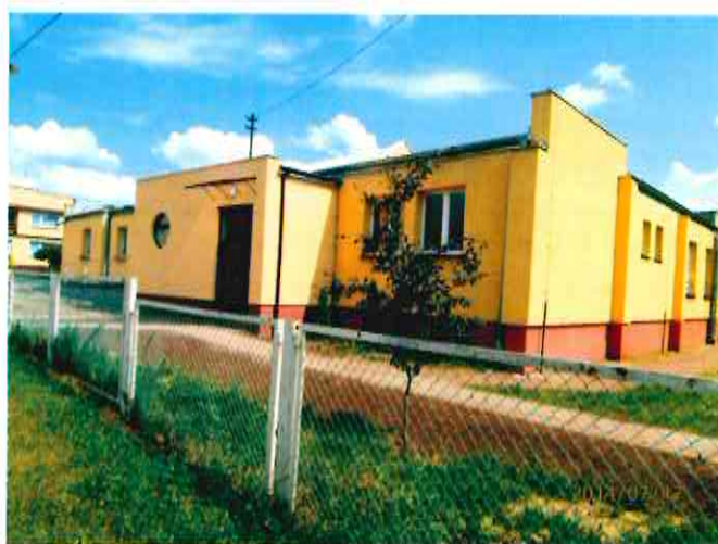
Przebudowane wejście do DPS Herby
