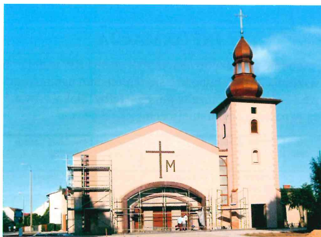
Budowa kościoła w Olszynie prace wykończeniowe na zewnątrz
