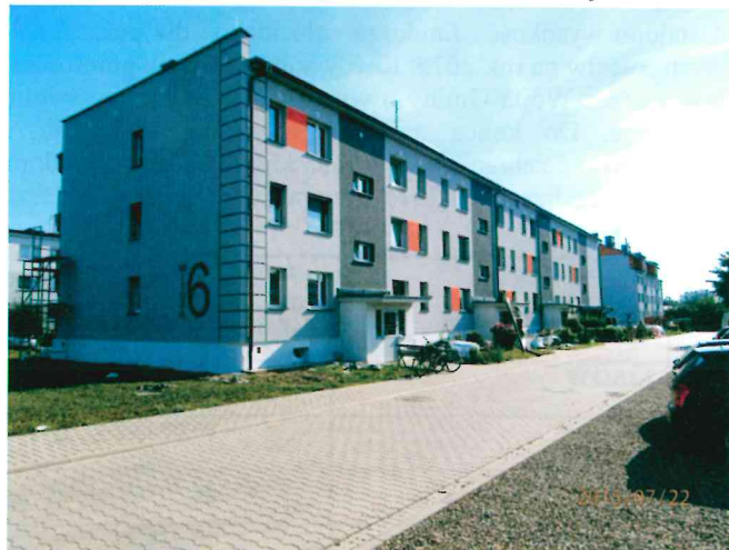
Blok w Lisowie ul. Witosa 6 - termomodernizacja
