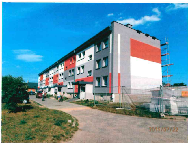
Blok w Lisowie ul. Budowlanych 9 -termomodernizacja
