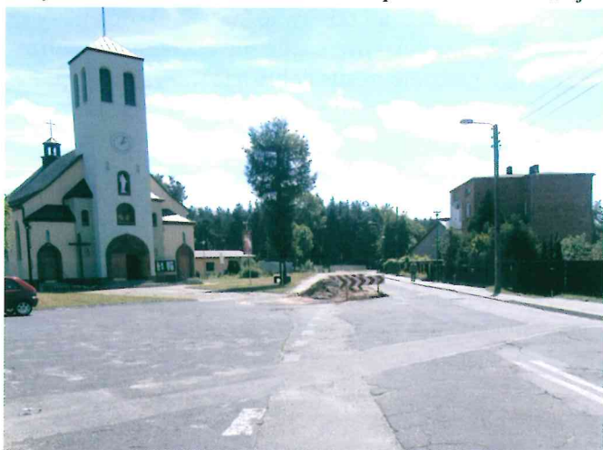
Budowa kanalizacji deszczowej na ul. Nowej w Herbach
