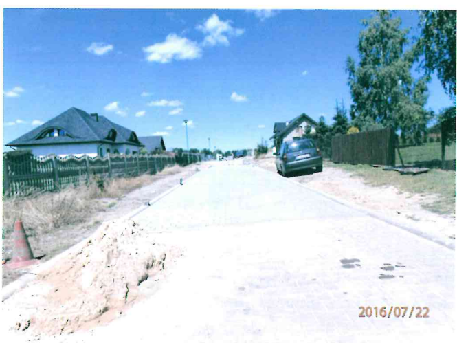
Modernizacja odcinka ul. Krętej w Lisowie
