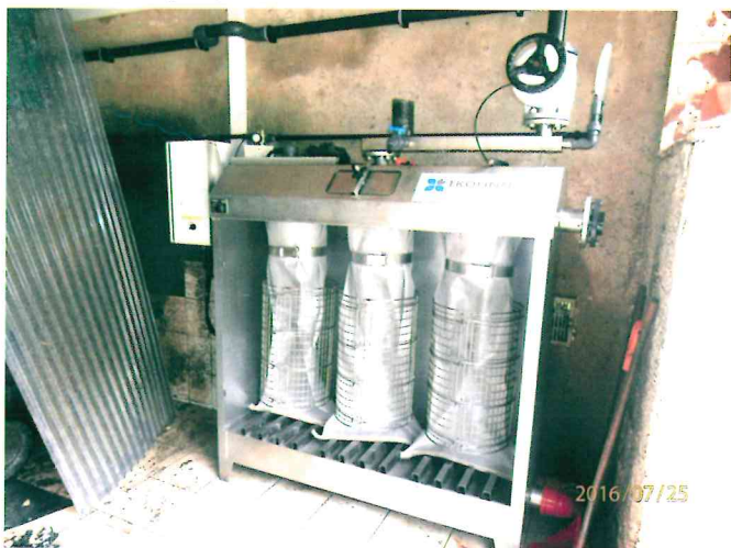
Oczyszczalnia ścieków Lisów –urządzenie do osadów
