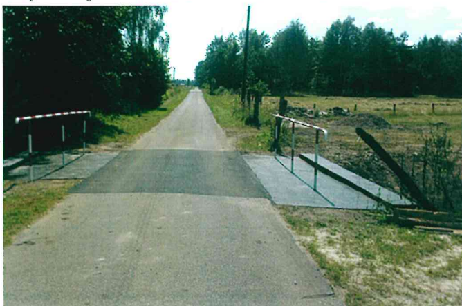
Most na drodze do Głębów po gruntownym remoncie
