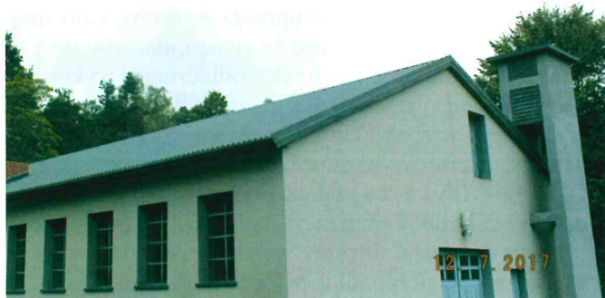
Nowy dach na kaplicy na cmentarzu komunalnym w Herbach
