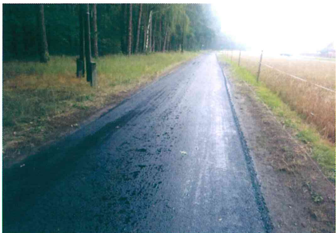
Nowa nawierzchnia na drodze w Braszczoku
