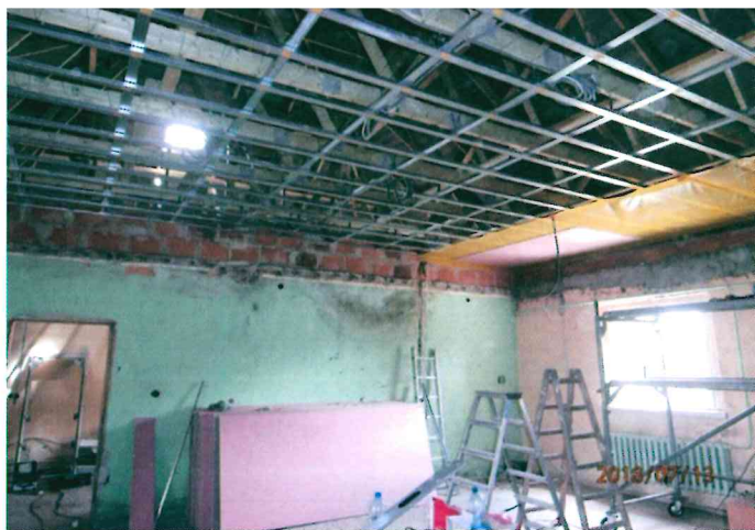
Remont w remizie OSP w Olszynie
