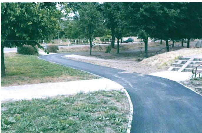
Budowa drogi rowerowej w Lisowie
