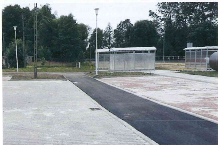
Budowa centrum przesiadkowego w Lisowie
