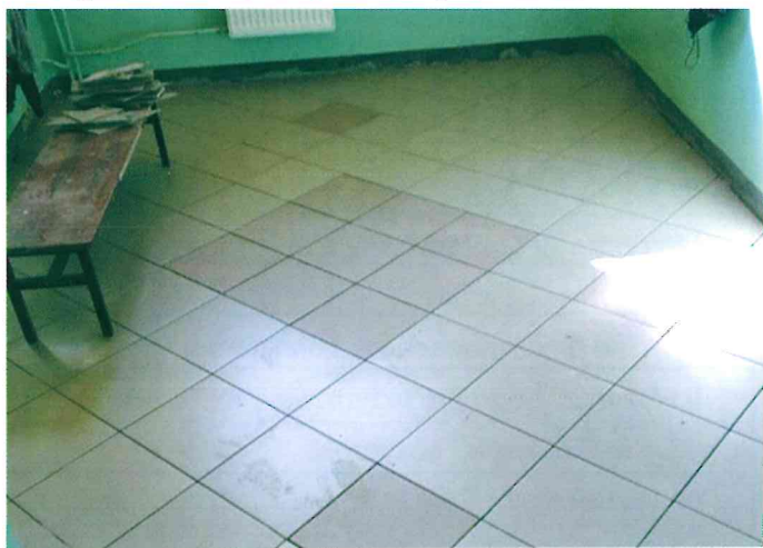
Nowa posadzka w szatni przy sali gimnastycznej w ZSP Lisów
