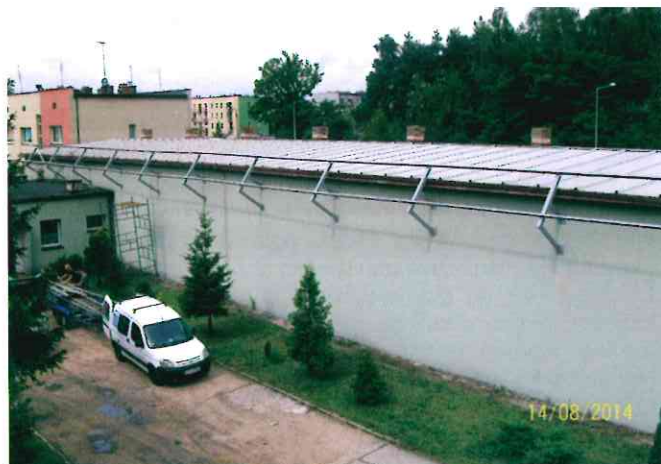
Montaż ogniw fotowoltaicznych na SUW Herby
