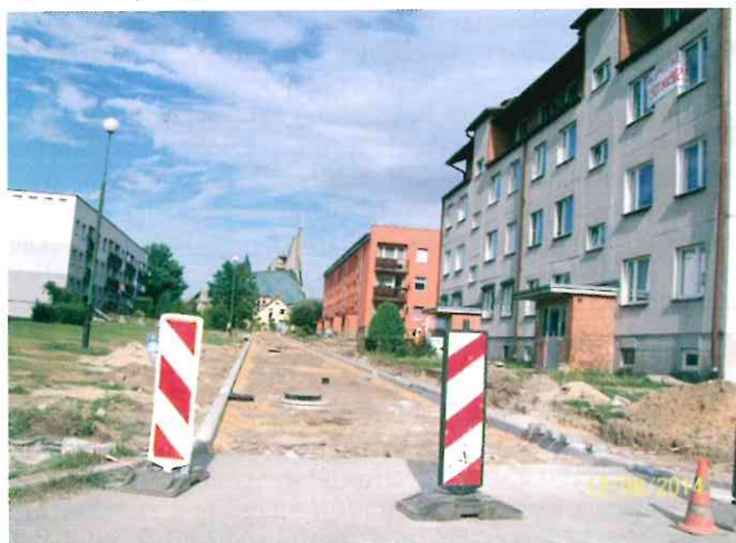
Prace remontowe na ul. Witosa nr 2 i 3
