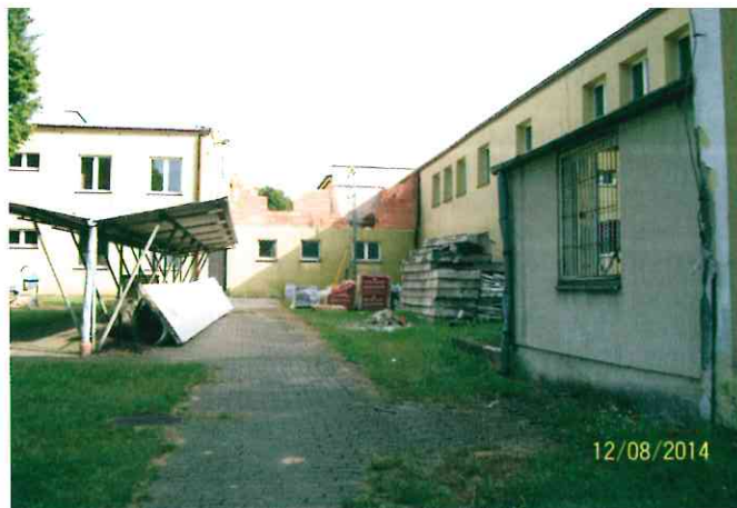
Nadbudowa łącznika budynku w ZPO Lisów
