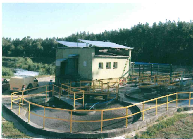
Ogniwa 9KW na oczyszczalni ścieków w Lisowie
