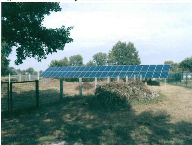
I budowane na 12 KW na ujęciu wody w Lisowie
