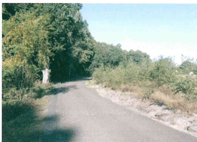
Droga do Głębów po modernizacji
